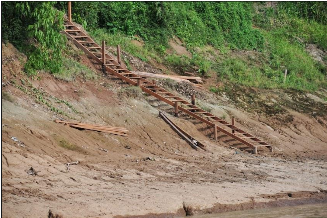
Escadas construídas no projeto Purus para Sr. Benedito (crédito da foto: Brian McFarland)
